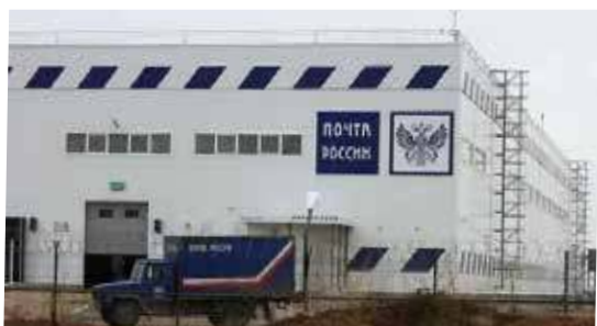
Новый логистический и складской комплекс Почта России в г. Челябинск. Главный распределительный щит (ГРЩ) и распределительные щиты.
