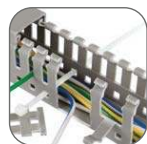
Отверстия под стяжки для крепления проводов
