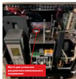
Рис. 3. Место установки расцепителя минимального напряжения
