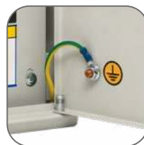
Обмедненные шпильки. Закрепленный поводок заземления
