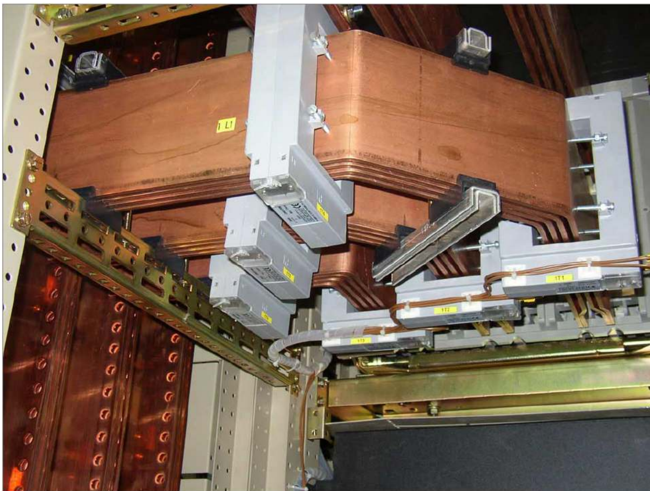
Монтаж трансформаторов тока в ГРЩ
